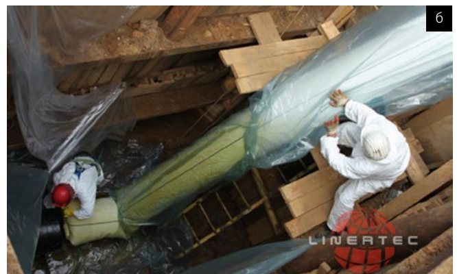
Рисунок 8. а — Схема установки CIPP, б — Фрагмент работы по футеровке подземного трубопровода
