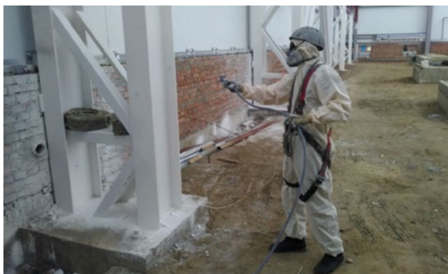
Рисунок 4. Нанесение толстослойного покрытия
