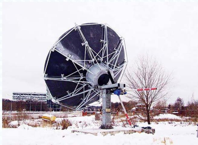
Реализованная композитная конструкция рефлектора обеспечивает высокую геометрическую точность рабочей поверхности и размеростабильность рефлектора при воздействии комплекса погодных и климатических факторов.
